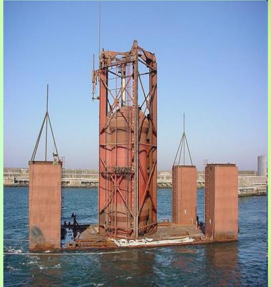
Хвильова станція нового проекту Archimedes Wave Swing
