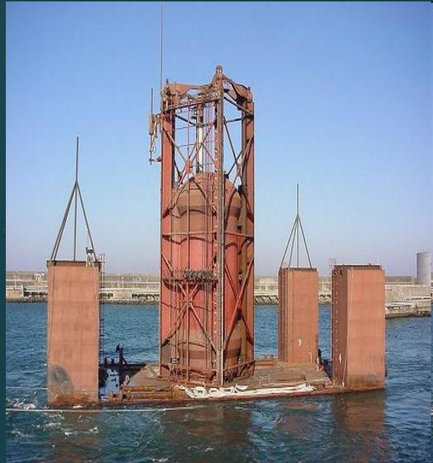
Хвильова станція нового проекту Archimedes Wave Swing
